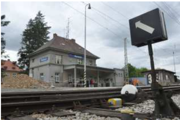
Železniční stanice Bechyně v pátek 21. 5. 2021.
