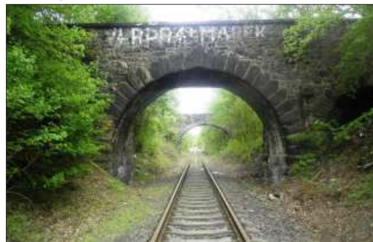
Trať Děčín – Oldřichov u Duchcova byla v loňském roce zbavena náletových dřevin (na snímku u Krupky ze dne 15. 5. 2021). Aby zde mohla být zavedena alespoň turistická osobní doprava, musela by zde být provedena kompletní výměna železničního svršku a spodku, což by vyšlo řádově na několik milionů Kč.
