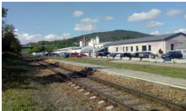
V těsné blízkosti bývalého placu jednokolejné dopravní RB Husinec leží firma Beton, po vytržení všech odbočných kolejí nemůže přepravovat po dráze ani kolo, i kdyby nakrásně chtěla naplnit myšlenku Evropského roku železnice 2021!
