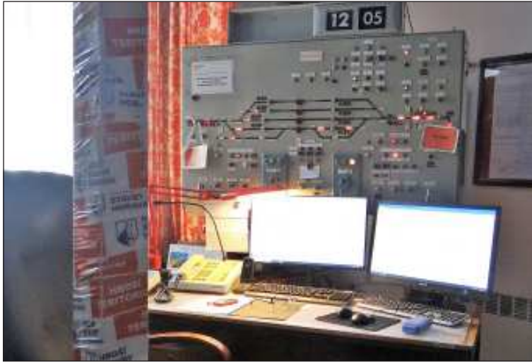
Po dobu bourání budovy podepírá strop v dopravní kanceláři dřevěný trám.
