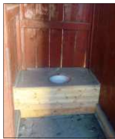
Vnitřek uklizených a udržovaných záchodů před likvidací, stav 18. 6., Mníšek p. B.
