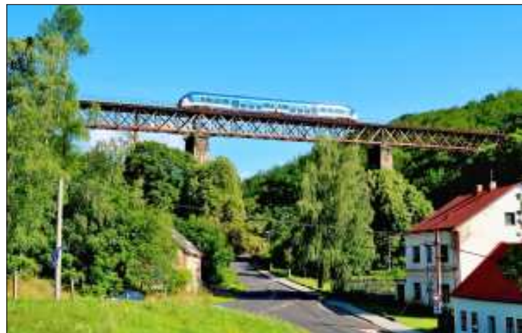
Po ocelovém přhradovém mostě v místní části Hrob–Mlýny právě projíždí motorový „Žralok“ jako víkendový SP 1956 v relaci Děčín – Moldava. Je neděle 1. 8., 9.20 hodin.
