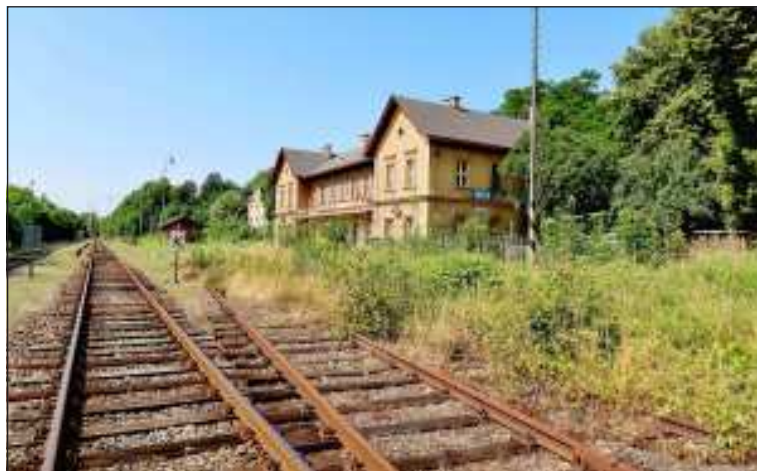
Staniční budova v Hrobu má již svá nejlepší léta za sebou. Dnes zarostlé kolejště připomíná zdejší někdejší čilý dopravní provoz.
