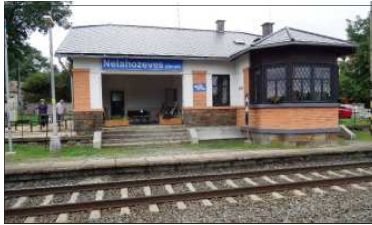
Nádražní budova zastávky Nelahozeves zámek, která patří Správě železnic, prošla v roce 2019 kompletní rekonstrukcí.
