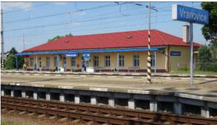
Železniční stanice Vranovice dnes.
