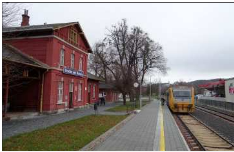
Budova i kolejště železniční stanice Hradec nad Moravicí byly opraveny v roce 2020.
