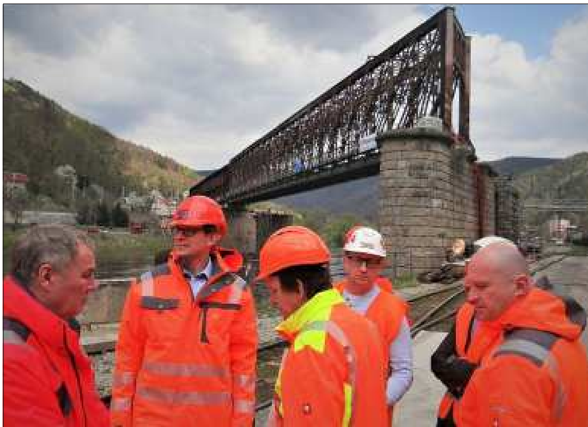
Ministr dopravy s doprovodem před částečně sneseným mostem přes řeku Labe.
