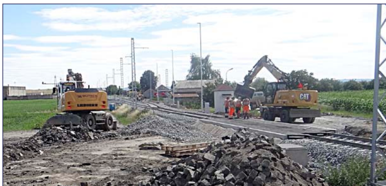
Oprava přejezdu v bývalé železniční stanici Troubelice, stav ke konci července 2022
