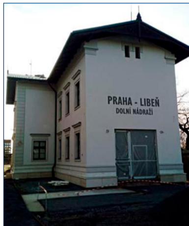
Nově opravená bývalá žst Praha-Libeň dolní nádraží, stav z 23. 3. 2023
