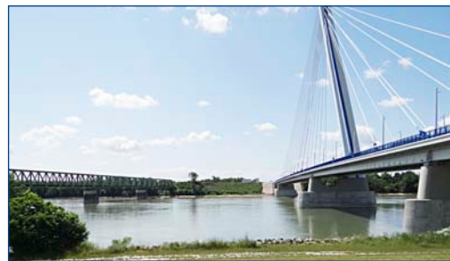
Železniční a silniční most z Komárna do Maďarska
