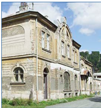
Současný vzhled budovy nádraží Hrubá Voda
