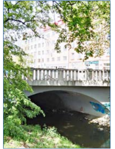
Pod mostem v Sokolovské ulici v Praze protéká Rokytka k sídlu OSŽ
