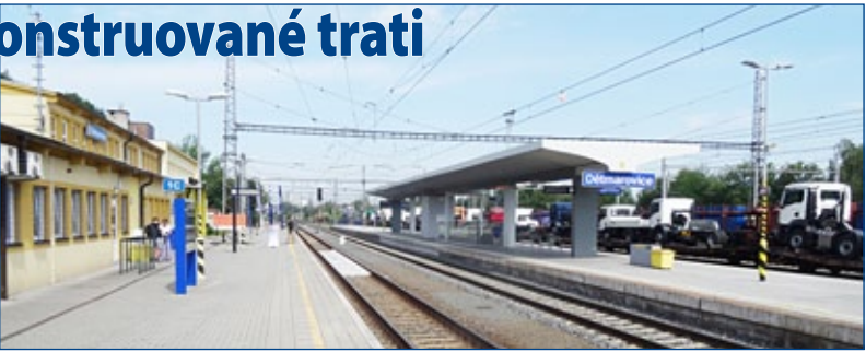
Rekonstruovaná železniční stanice Dětmárovice
