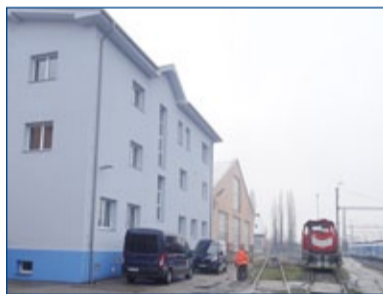
Rekonstruovaná strojmistrovská budova v obvodu OCÚ Východ v Olomouci
