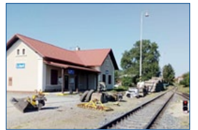
Budova žst. Liteň (DOZ Zadní Třeboň), stav při výluce 13. 5., budova je opravena, ale uzavřena jako neobyvatelný sarkofág
