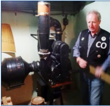
Filtroventilační zařízení zajišťovalo čistý vzduch a mohlo být poháněno i lidskou silou
