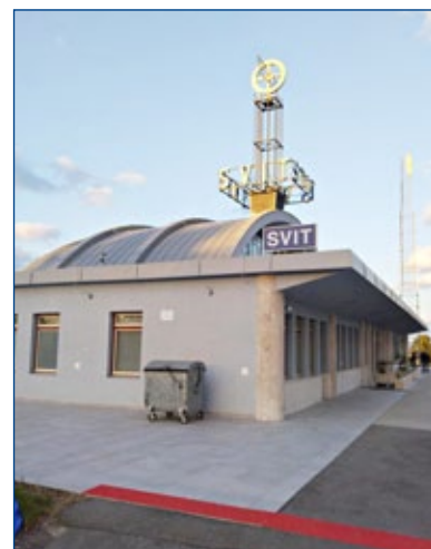
Opravená budova železniční stanice Svit se symbolem okřídleného kola
