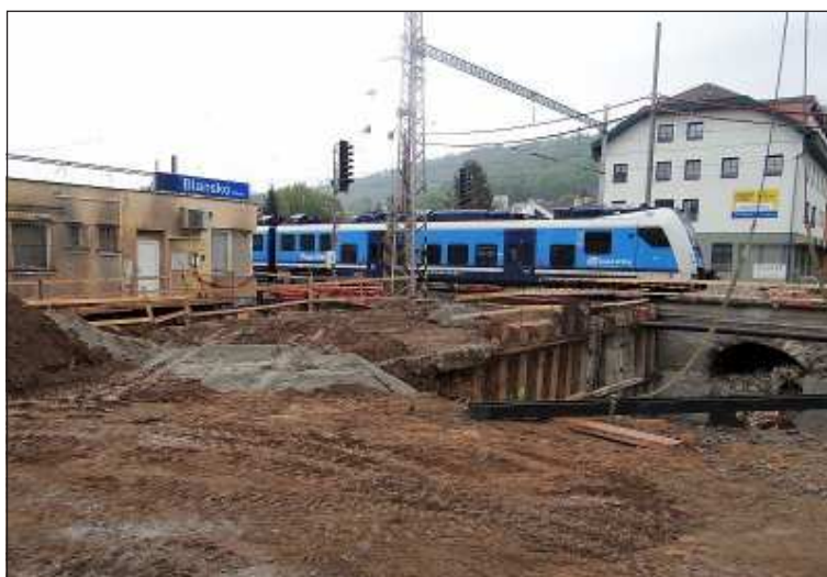
Dosavadní zastávka Blansko město bude demolována bez náhrady. Na jejím místě vznikne parkoviště.
